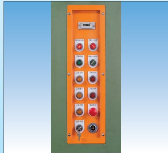
▲ 電機系統操作盤 Electrical Operation Panel
